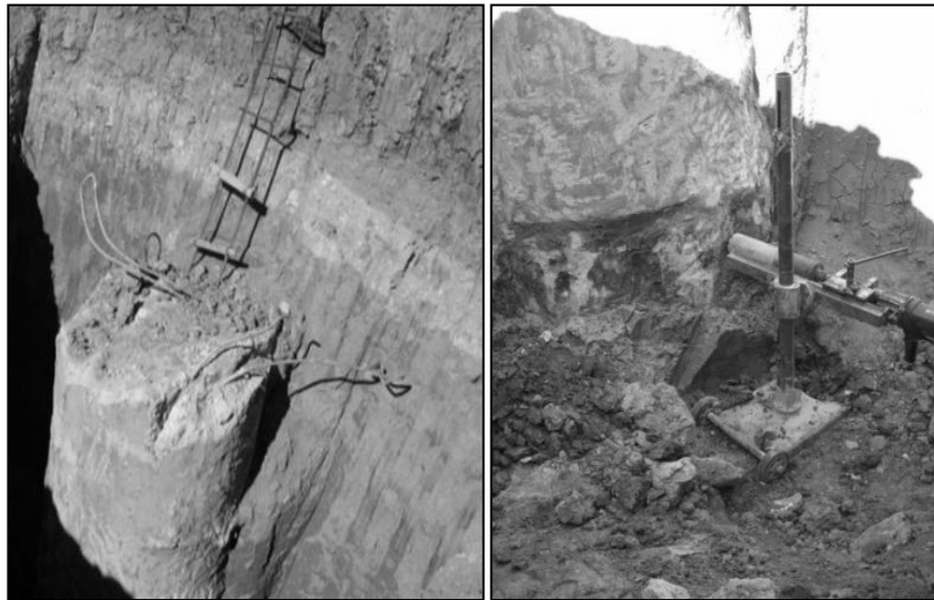
شکل ۳- خاکبرداری اطراف شمع، استقرار دستگاه مغزه گیر و نمونه برداری از بتن سخت شده
